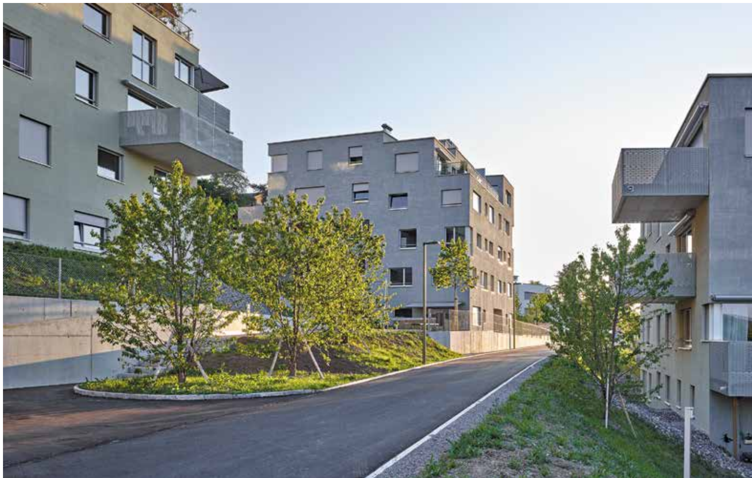
Mehrfamilienhäuser erweisen sich in der Bewertung als besonders stabil: Neubau «Hohfurri» in Winterthur, erstellt von Allreal, Architektur Beat Rothen (Bild: Allreal).
